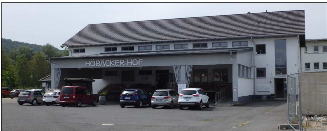
Abb. 3: Blick von Norden auf das Gebäude des „Höbäcker Hof“ (Quelle: PGNU, Frankfurt/M., Juli 2021)
