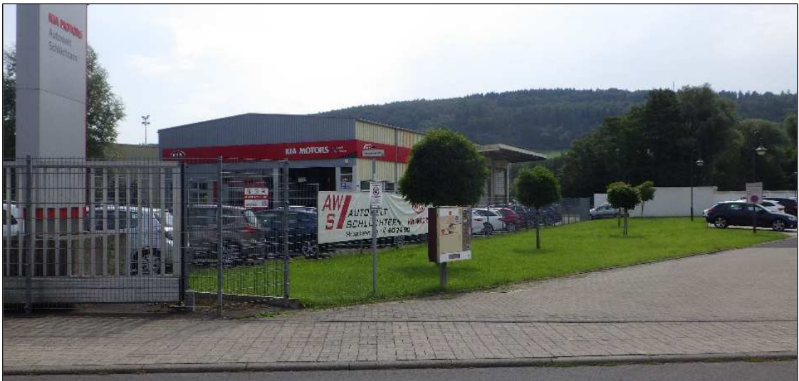
Abb. 7: Blick von Westen auf die Zufahrt zum Höbäcker Hof und das Gebäude des Autohauses AWS (Quelle: PGNU, Frankfurt/M., Juli 2021)
